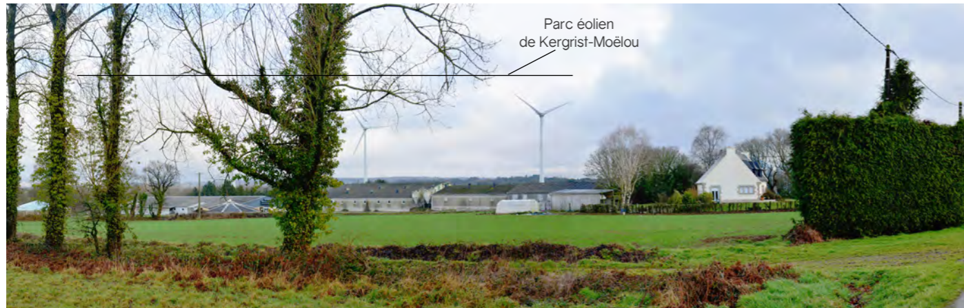
Photo 105 : Vue sur le projet depuis l'est de Coat an Barz
